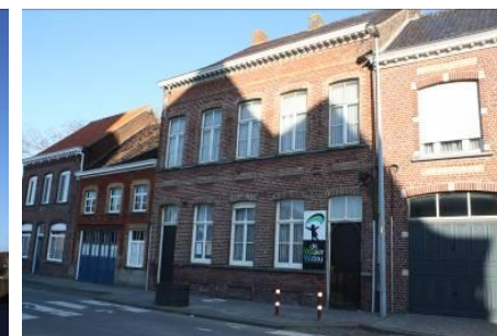
bestaande toestand deelzone B
