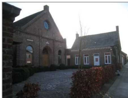
bestaande toestand deelzone D
